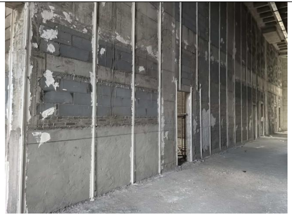
项目租用厂房内部
