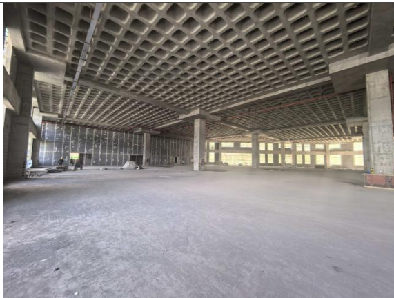
项目租用厂房内部
