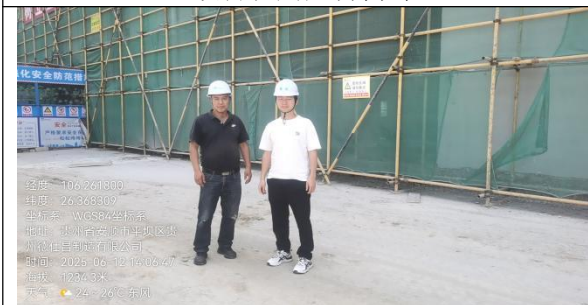
工程师现场踏勘照片（左）
