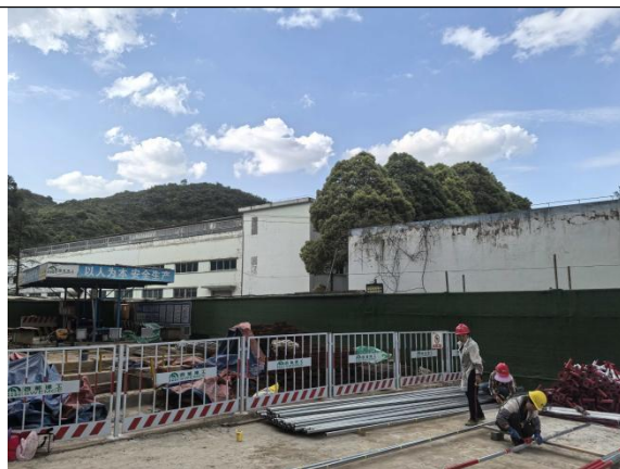
项目东北侧贵州黎阳国际制造公司
