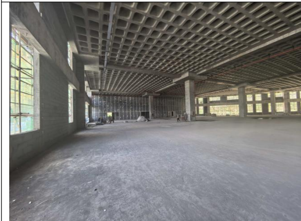
项目租用厂房内部
