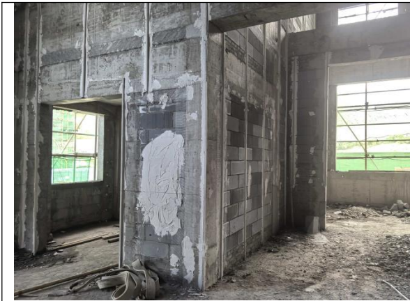
项目租用厂房内部
