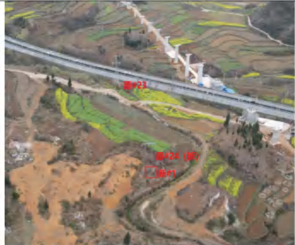
1-2 拆原 24#, 新建#1（航拍于 2025 年 5 月 10 日）
