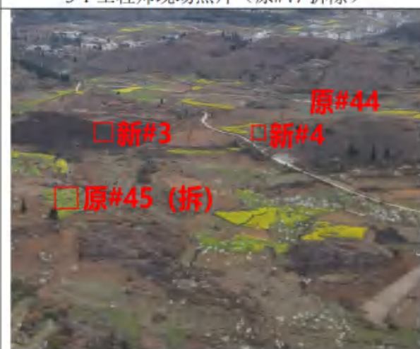
3-3 新#3/4, 拆45 (航拍于2025年5月10日)
