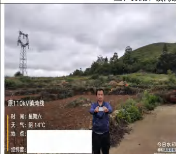
3-1 工程师现场照片 (原#47 拆除)
