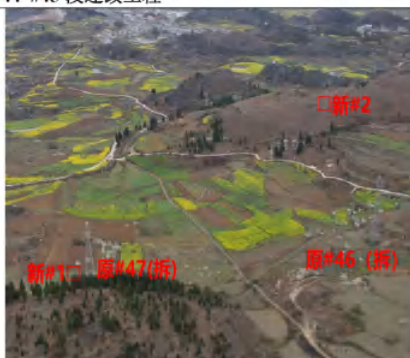
3-2 新#1/2, 拆 46/47 (航拍于 2025 年 5 月 10 日)
